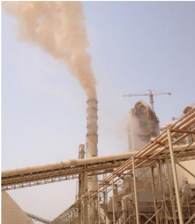
Zepsuty filtr workowy, który może podlegać monitorowaniu i rejestrowaniu.
